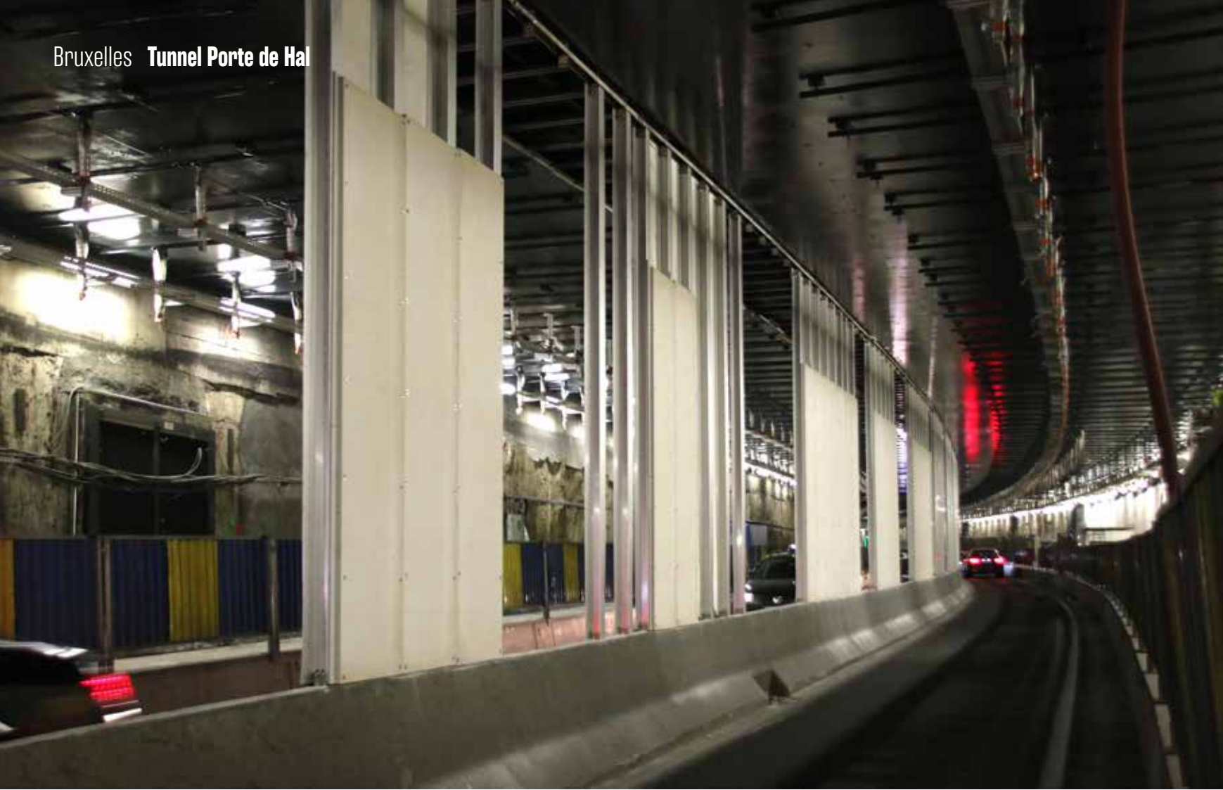
La cloison de séparation entre les deux sens de circulation a également été pourvue d'une protection incendie.
